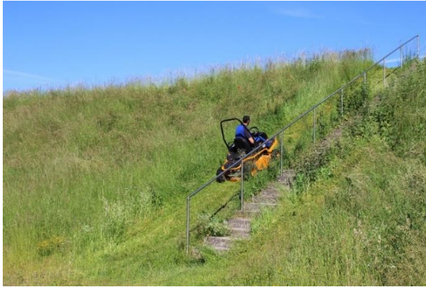
Bild 2: „Beim Mähen der Dämme muss auf den richtigen Zeitpunkt geachtet werden. Wenn es zu feucht ist, entstehen Schäden, die wir über Jahre mitziehen“, erklärt Stauwärter Martin Schmid.
